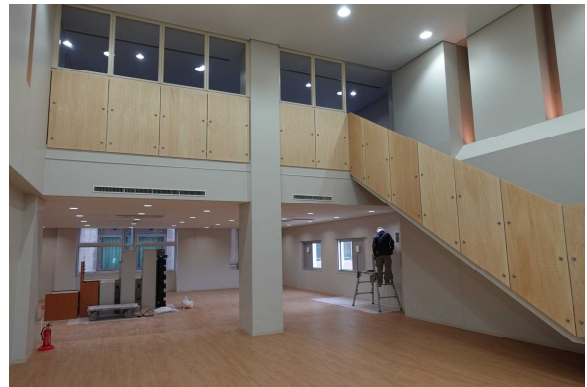
【リニューアルする図書館（完成間近）】
